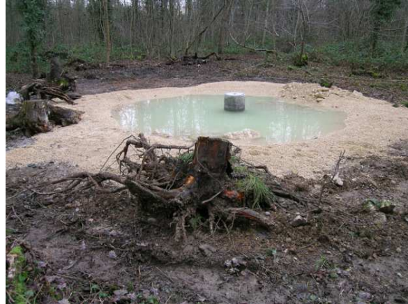
Zwei verlandete Weiher wurden vollständig neu erstellt und mit einer Ablassvorrichtung versehen.
